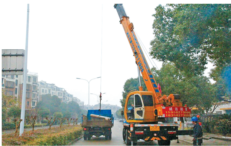
图为“拔杆”现场。
