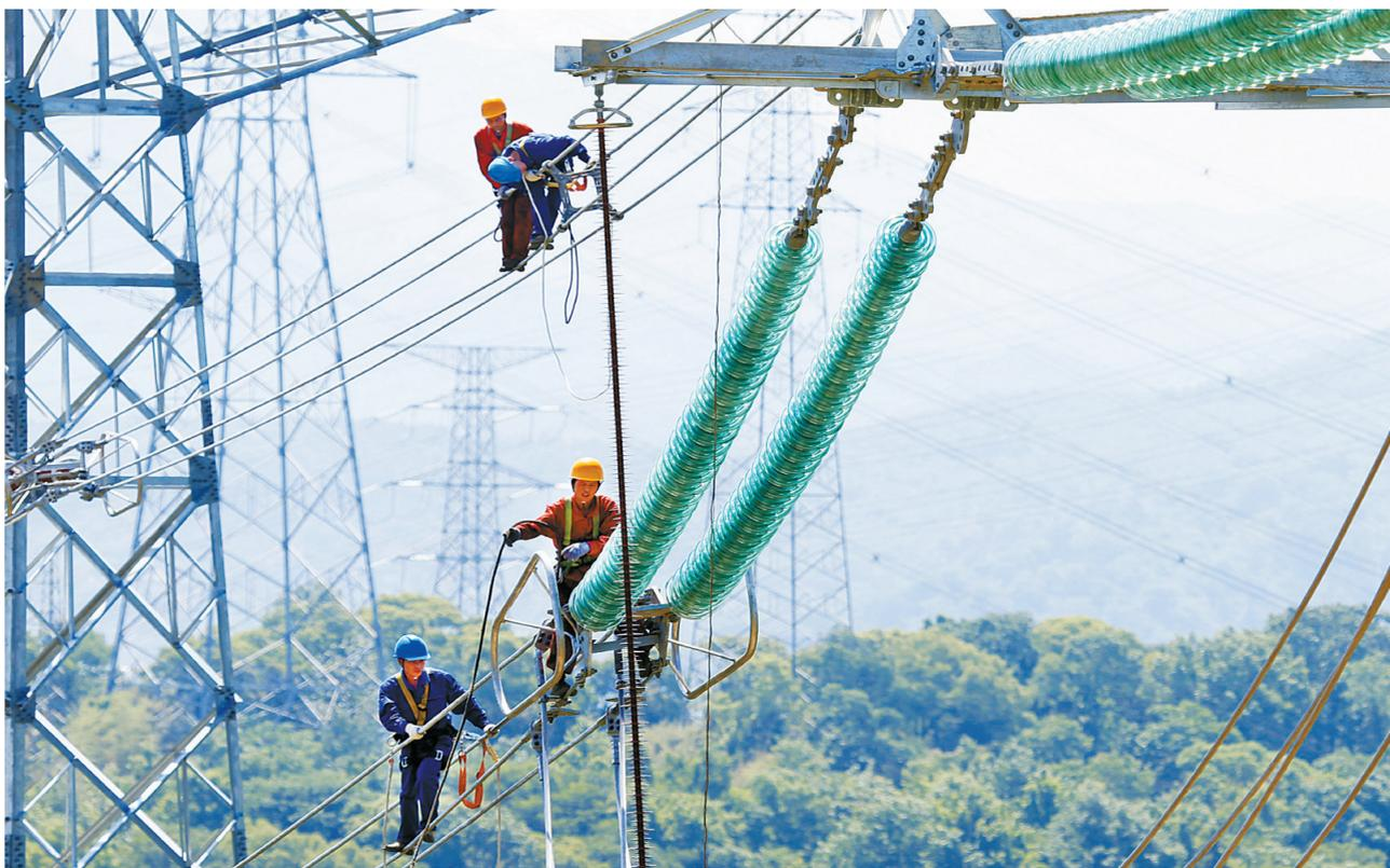
工作人员正在走线验收500千伏明州变至宁海电厂改接输电线路。
