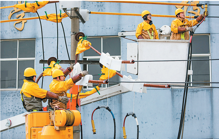
昨天上午，國網鄞州區供電公司帶電作業員工冒嚴寒對10千伏沙場支線的智能開關實施帶電更換，確保施工期間居民和企業不斷供電。據悉，這也是寧波地區首例採用旁路作業法更換智能開關。（徐能 鄭之超 攝）
