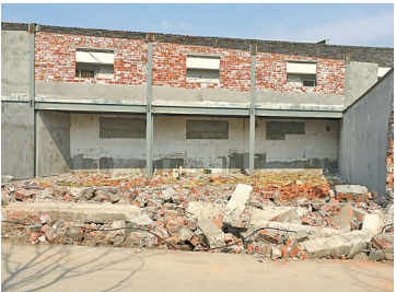
2月4日，该处违建已经被拆除大半。（钟海雄 摄）
