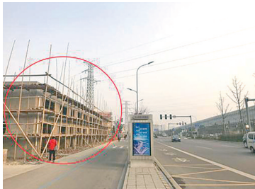
1月23日，记者在现场所拍的违建。（方琴 摄）
