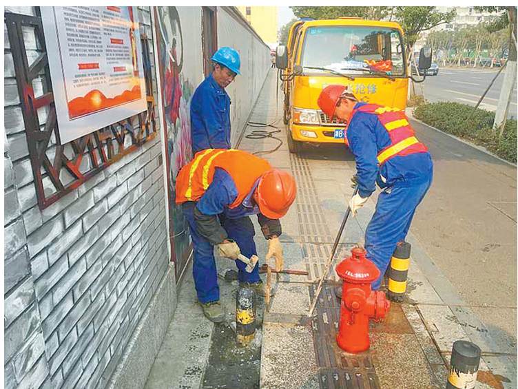
宁波自来水公司的工作人员拆除“拦路消防栓”。(陈结生 摄)
