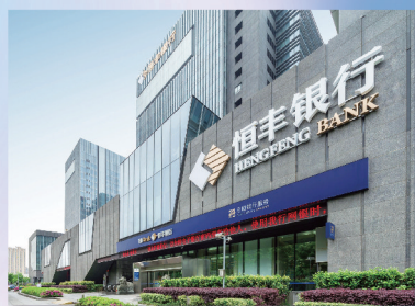
恒丰银行宁波分行营业部 地址: 鄞州区民安东路280号
