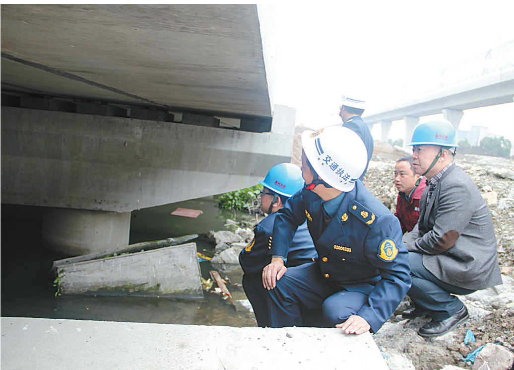
市交通质监站有关负责人在工地现场检查。
