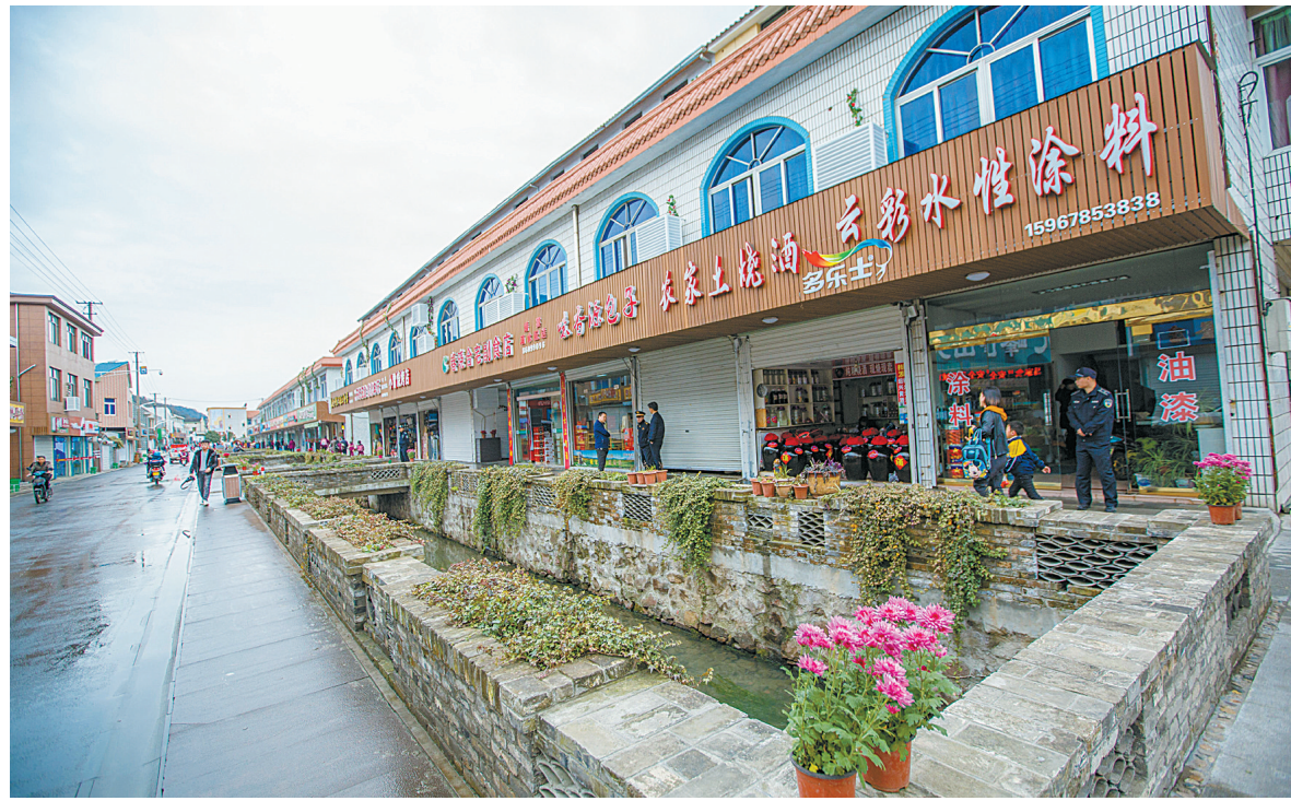
三山村掀掉溪坑盖板,清澈溪流重现。
