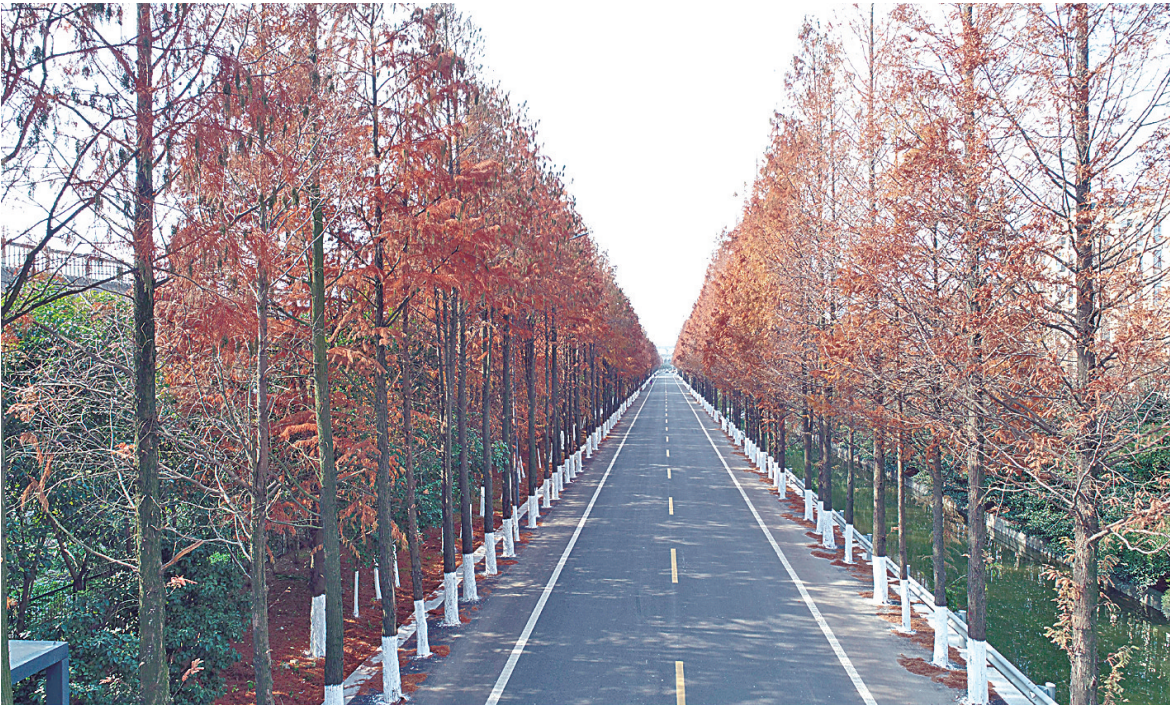
图为改造提升后的压观线。
