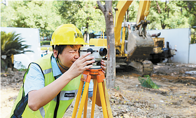
勘测排水管网
