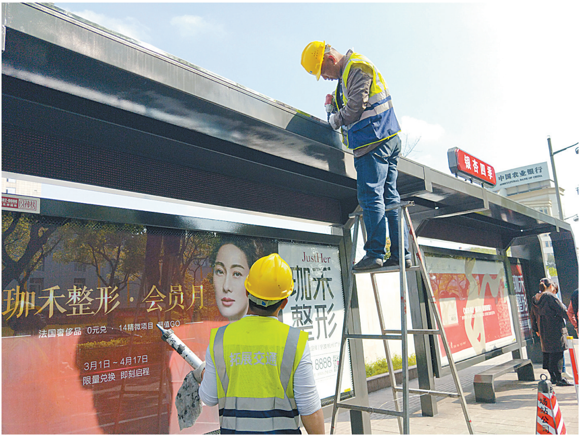
昨天下午，工作人员在银杏四季公交候车亭安装挡水条。
