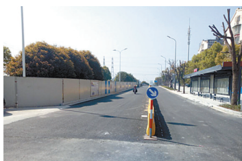
西半幅道路已经通车。 (傅钟中 摄)
