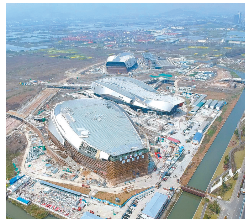
重点民生项目工程宁波奥体中心
