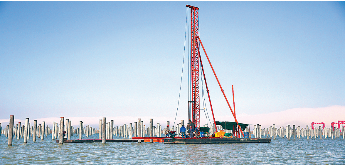
图为项目建设现场。(金旭 沈孙晖 摄)
