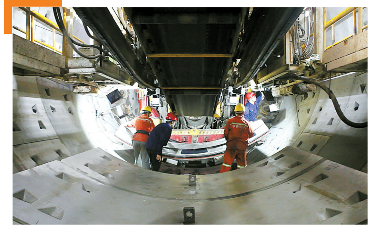
活跃在轨道交通4号线建设阵地的青年突击队。
