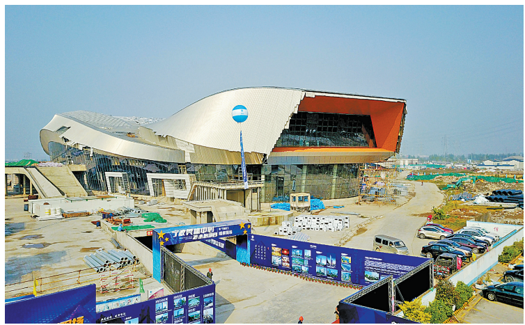
图为游泳馆主体工程建设完成。(徐欣 摄)
