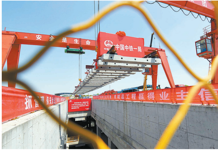
在大通桥站,工人正在利用龙门吊对拼装好的首段轨排进行施工作业。(记者 徐文杰 摄)
