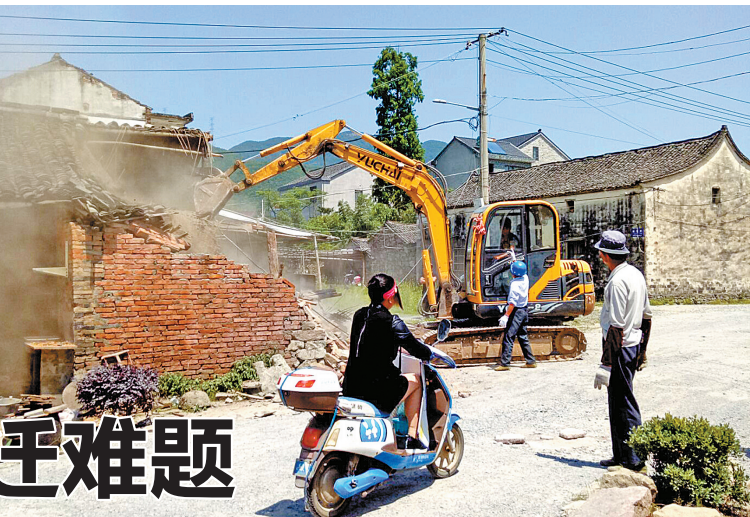
图为拆除现场。（沈孙晖 赵媛 摄）
