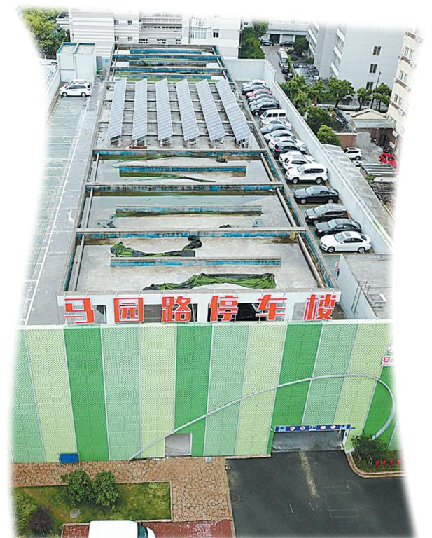
▲马园路停车场安装的光伏发电装置,每年可为停车场提供12%的电力供应。(刘波 摄)
