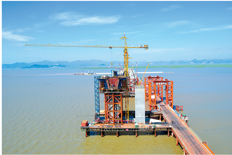
图为建设中的三门湾大桥。(宁波交投公司供图)
