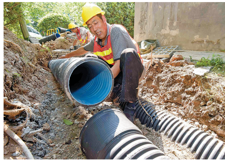
昨天,在江北区文教街道双东坊社区里,工人们正在进行污水零直排改造作业。根据市、区两级“剿灭劣V类水”和“污水零直排区”创建工作安排,文教街道计划今年对辖区内的9个老旧小区开展该项改造工作。(徐文杰 谢斌 摄)
