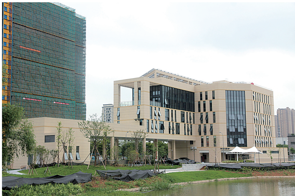
图为已完工的市中医院北侧公交综合体。
