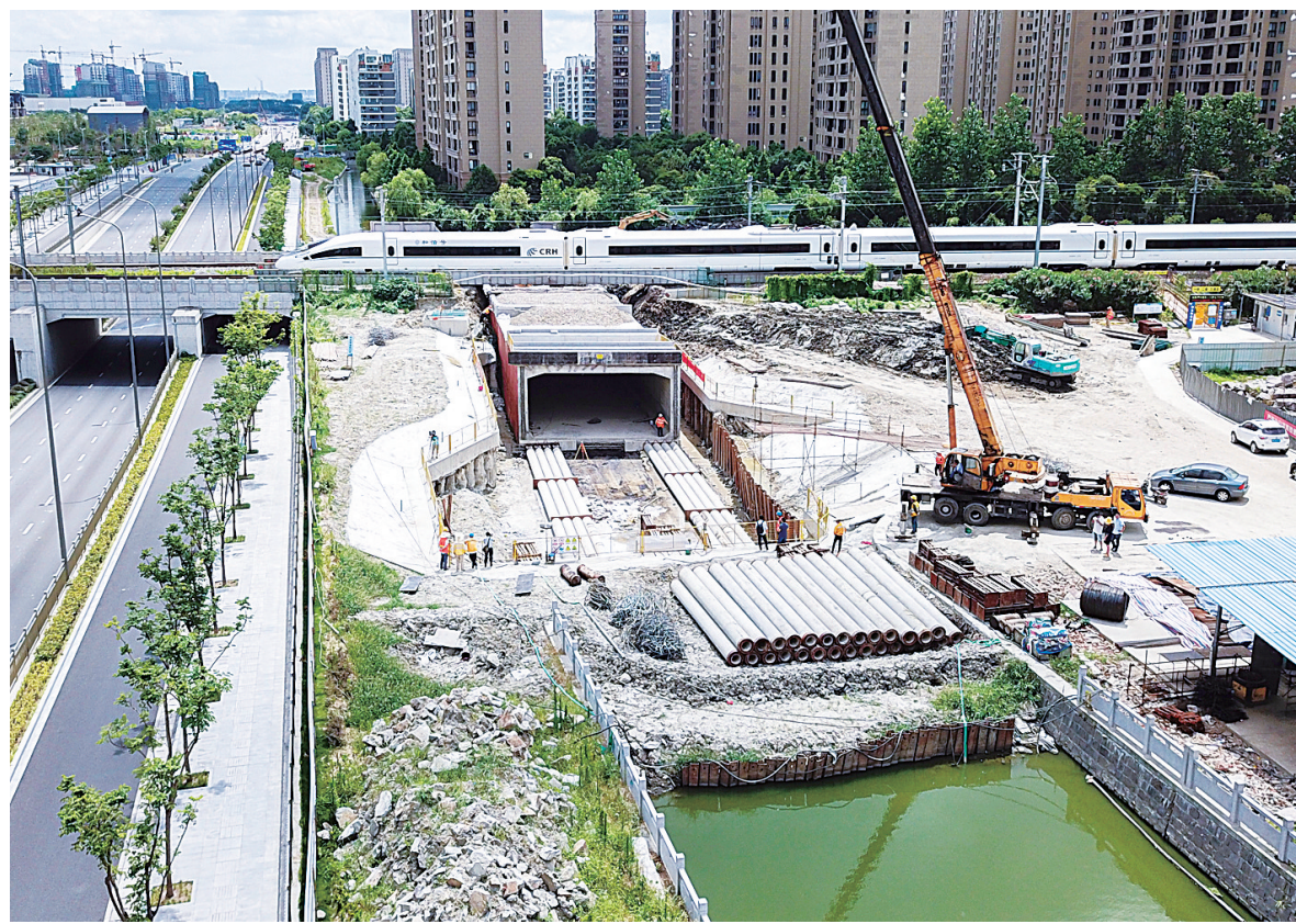
图为铁路下穿箱涵顶进作业现场。
