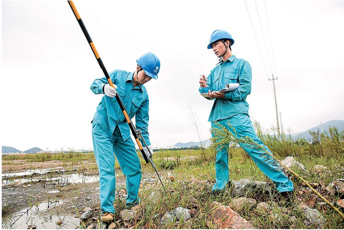
昨日,电力工人正在对10千伏嵩城线进行安全隐患排查。当天,国网宁波供电公司启动防台风Ⅲ级应急响应,各单位应急指挥中心进入24小时应急值班状态,全市已集结输变配各类抢修队伍269支。
