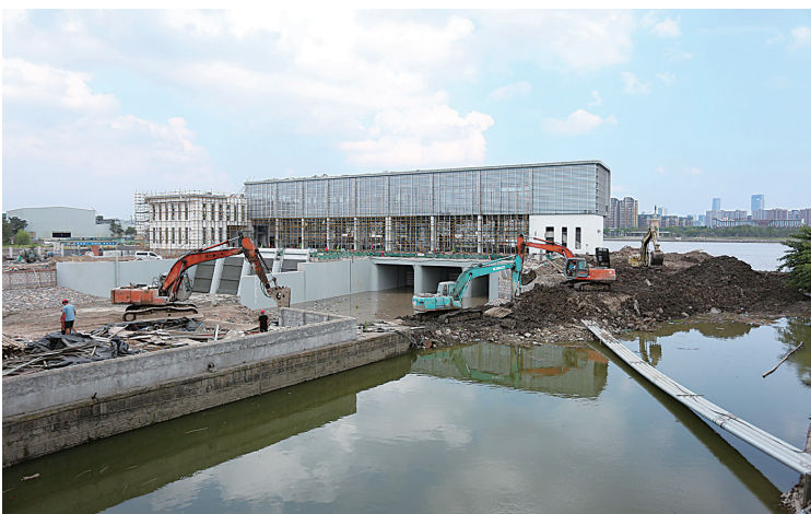
孔浦闸站新建工地上,工人在紧急疏浚新河口。(徐欣 王涛 摄)
