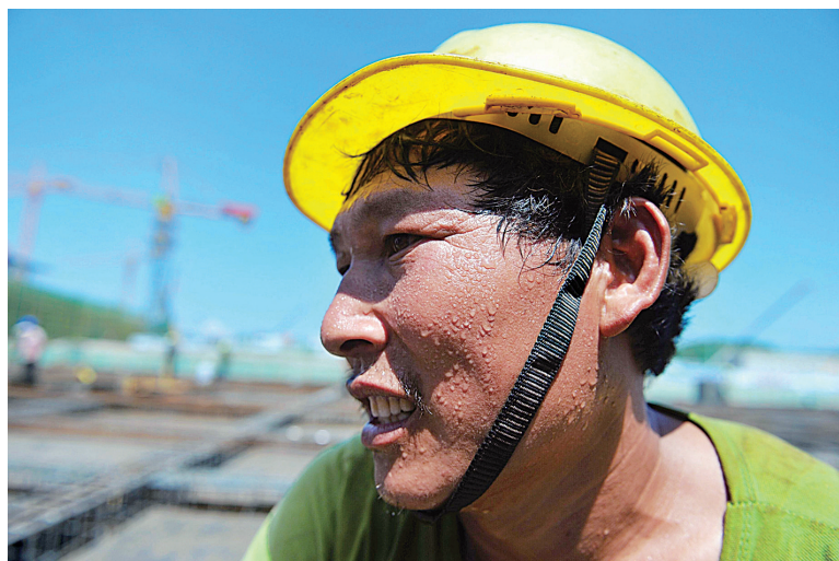
在山东青岛火车站建筑工地，一名工人在铺设钢筋（8月3日摄）。（新华社发）
