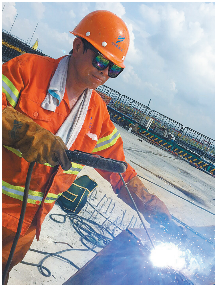
施工现场,电焊工顶着烈日焊接钢架。(张燕 岳峰 摄)
