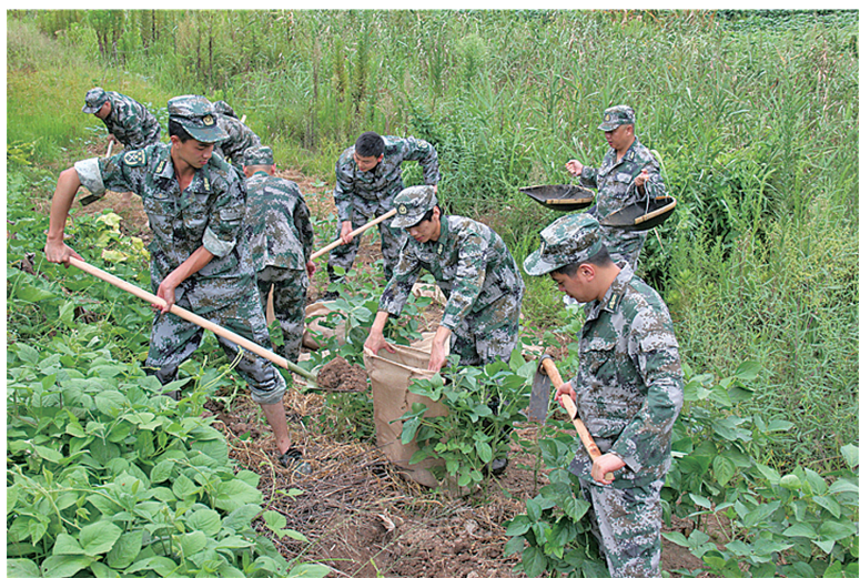
台风“摩羯”来袭,宁海县越溪乡人武部组织应急民兵小分队抢险加固白桥港及灰场塘百余米的缺口。(杨矜矜 摄)
