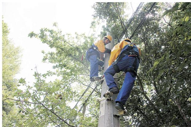
带电作业班的电工穿戴着厚而不透气的专用装备爬上电线杆作业。(孙勇 徐展新 摄)
