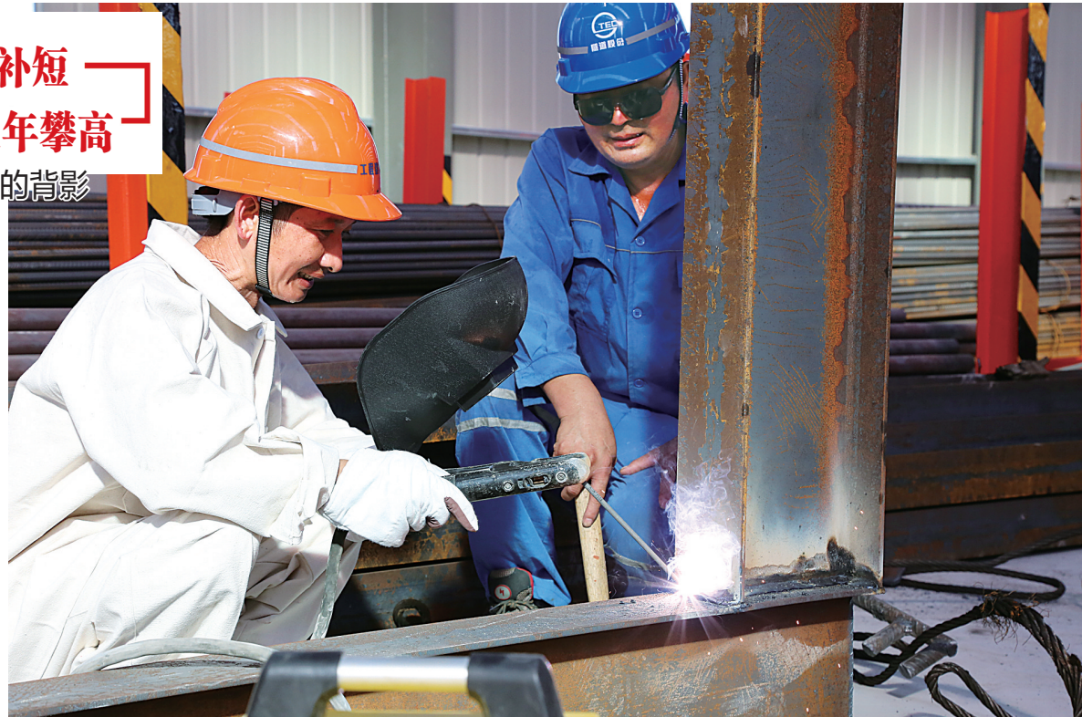
欧海云(左)正在焊接钢筋。
