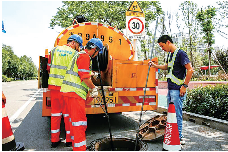
图为市政养护人员在疏通下水道。(徐欣 摄)
