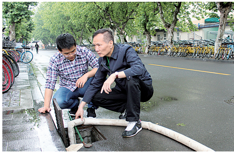
图为余建海（右）在检查小区下水管道。（徐欣 沈旦 摄）
