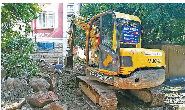
施工人员在挖掘管道沟。（朱军备 摄）
