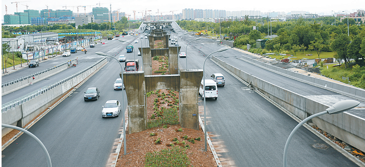
北环快速路临时贯通工程路面。
