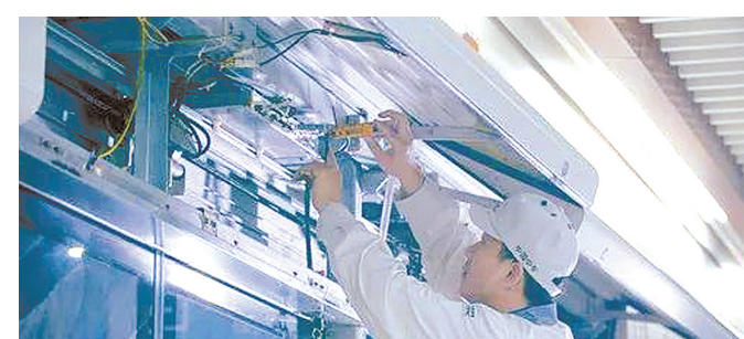
宁波中车时代公司员工在安装站台门。
