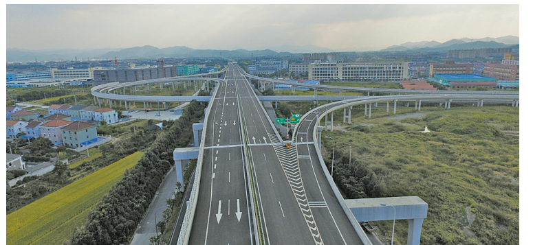
16日零时,慈余高速公路正式通车。这条高速公路大大方便了慈溪地区车辆前往甬南高速公路,也给余姚地区车辆前往杭州湾跨海大桥带来便利。图为马渚互通。(张燕 邓雪 摄)
