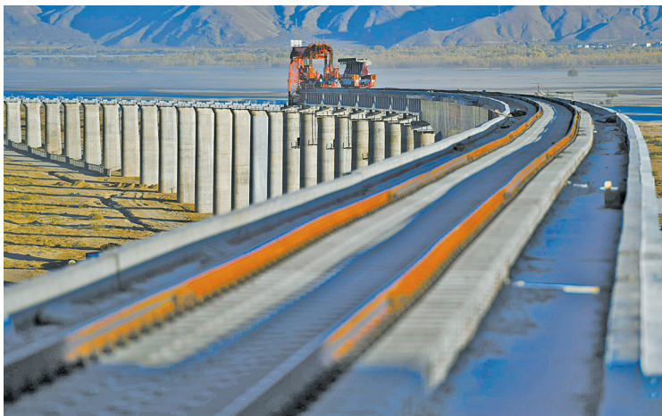
中铁十一局的工人在川藏铁路拉林段昌果特大桥进行铺轨作业。
