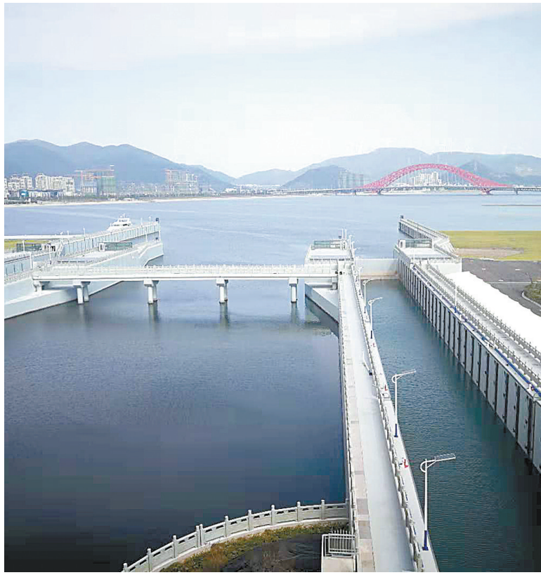
梅山水道工程南堤船闸。
