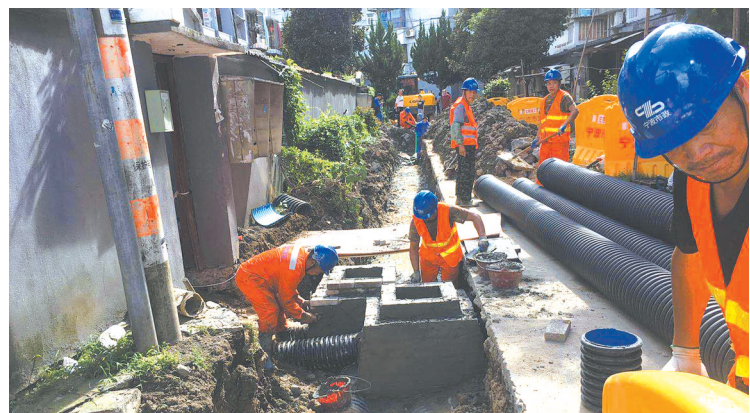
段塘街道启文花园老旧小区雨污分流改造
