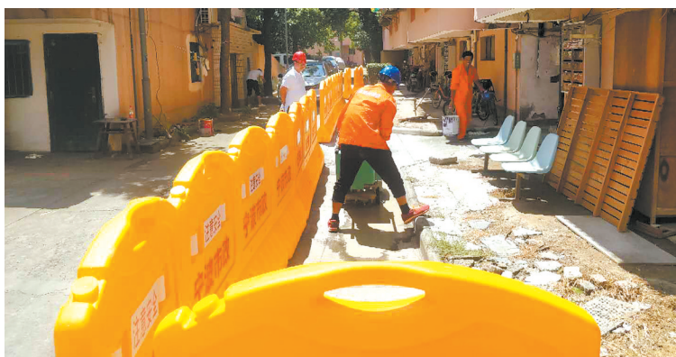
金地小区施工现场
