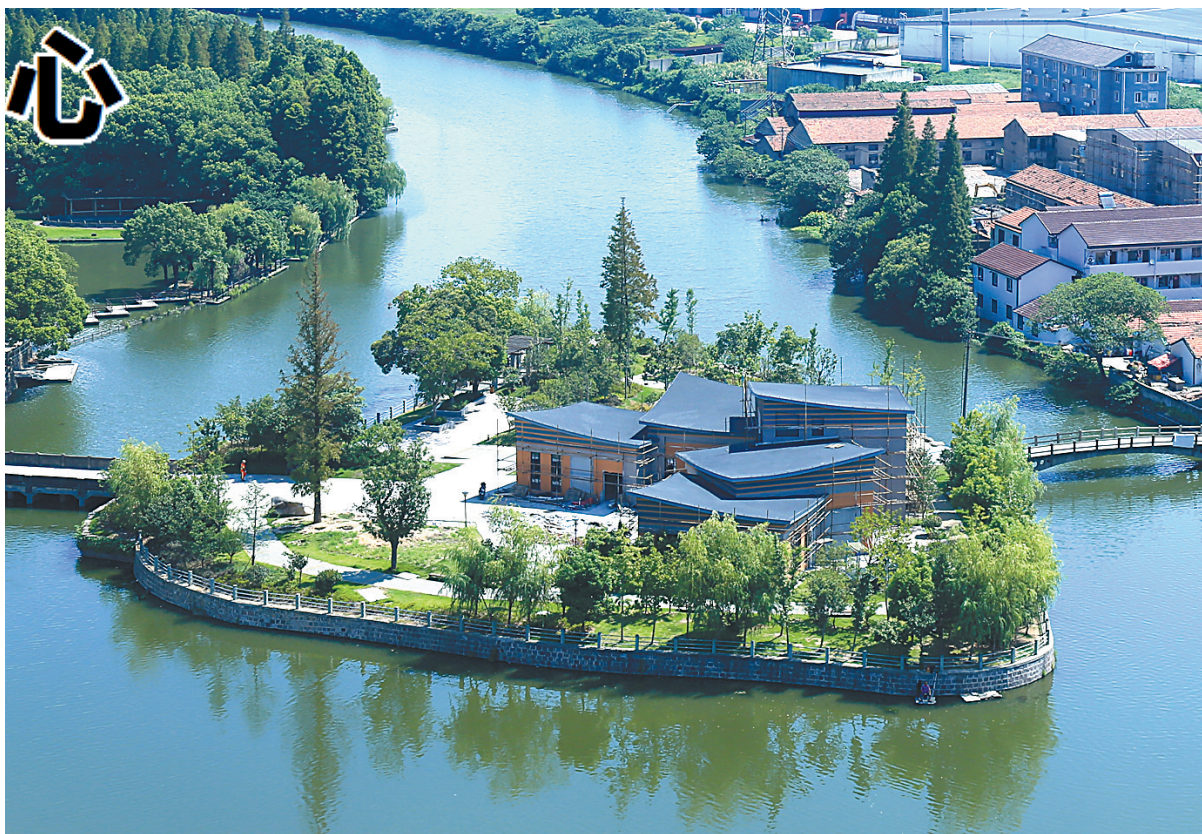
建设中的北仑开发开放展览馆
