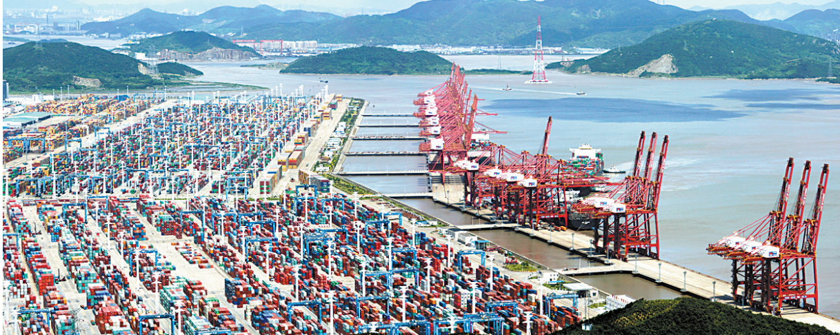
宁波舟山港穿山港区
