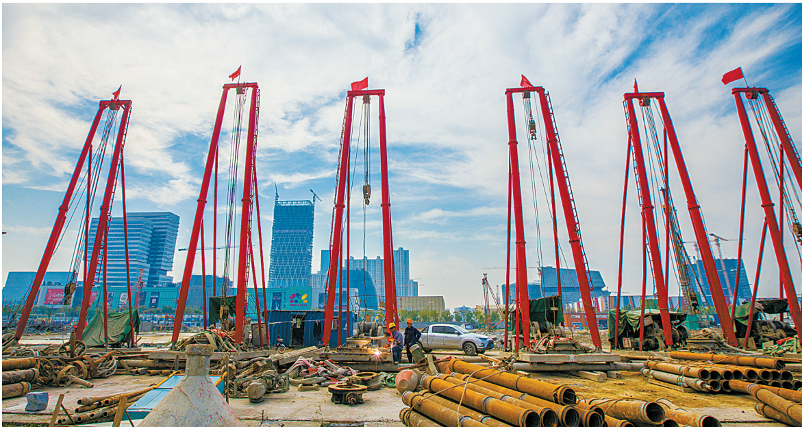
30日，东部新城中央公园工程开工建设。
