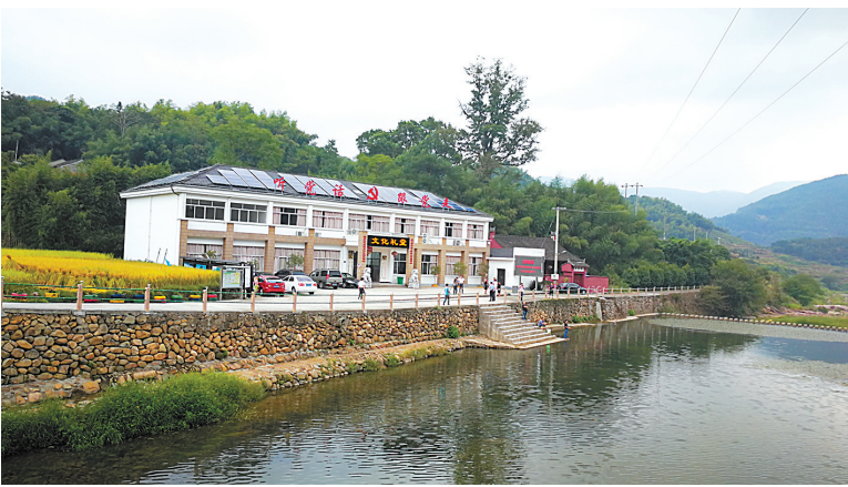
奉化张家村的屋顶上铺满了光伏发电板
