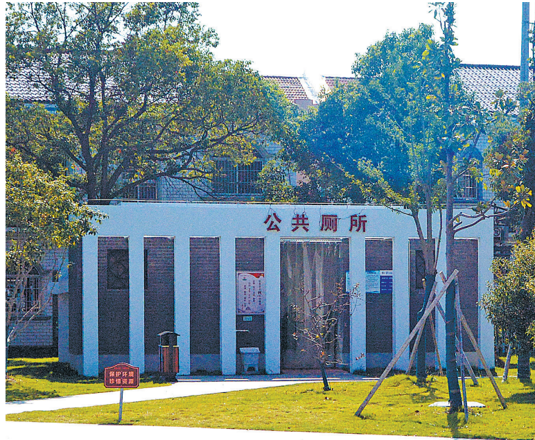
图为改造后的匡堰镇文化休闲广场公厕。
