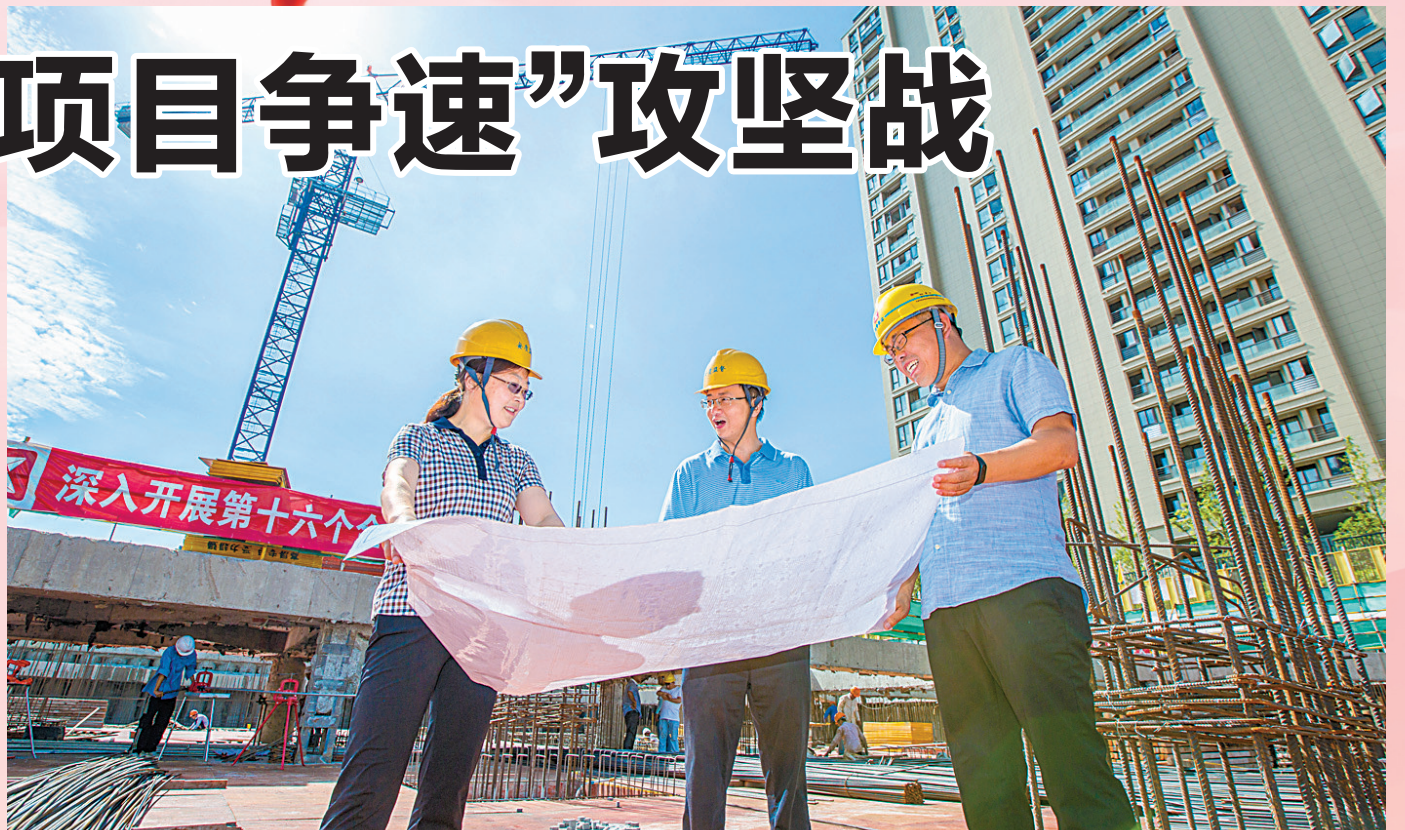
项目工作人员在工地现场研究细化施工方案。
