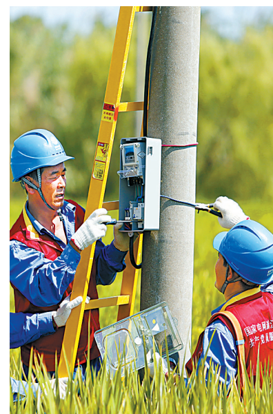
电力工人进行农排线路改造。
