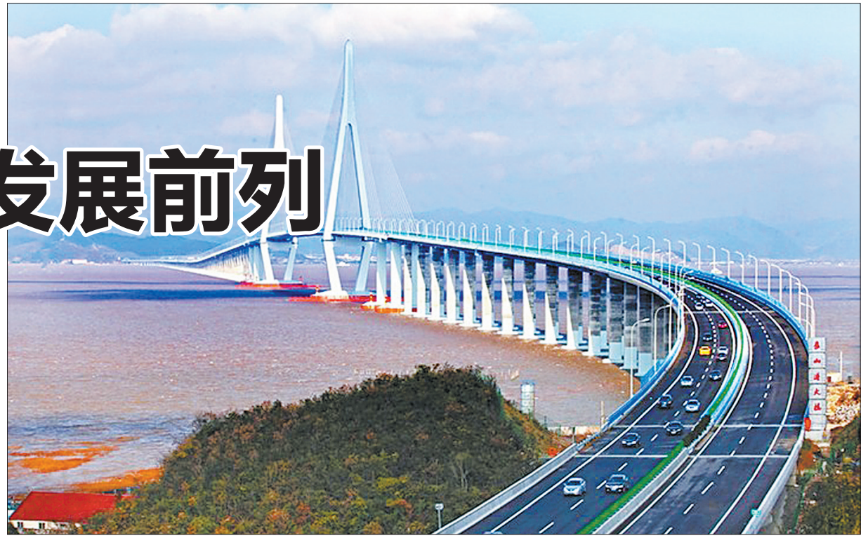
象山港大桥建成通车, 使得象山和宁波之间天堑变为通途。(资料图)
