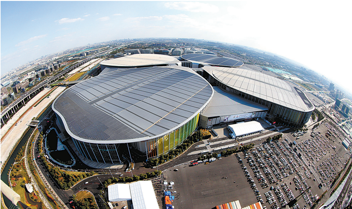
这是2018年10月19日无人机拍摄的首届中国国际进口博览会主场馆——国家会展中心（上海）。（新华社记者 凡军 摄）
