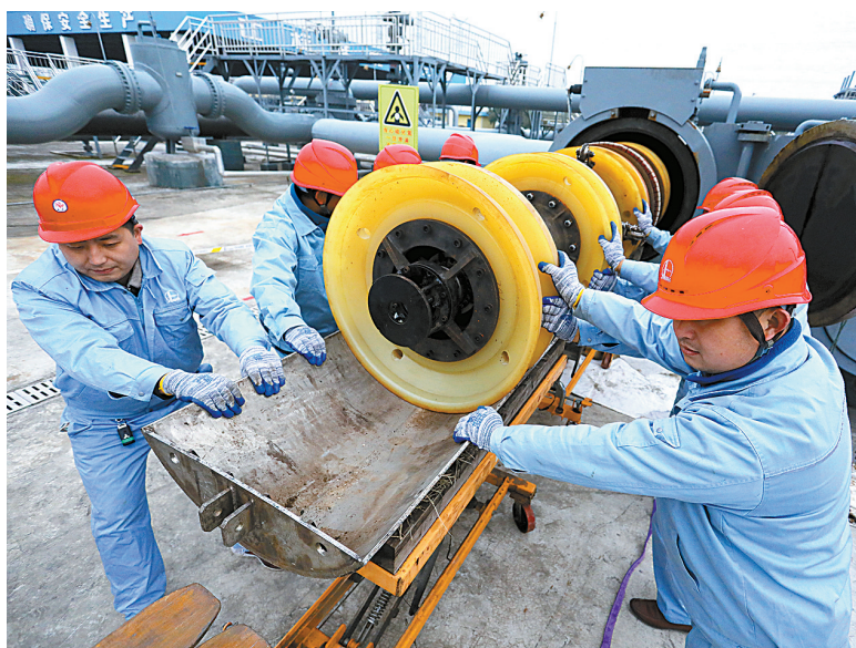
14日上午,在宁波输油处岚山站,工作人员将内检测器放置到进球筒进口,准备发出。
