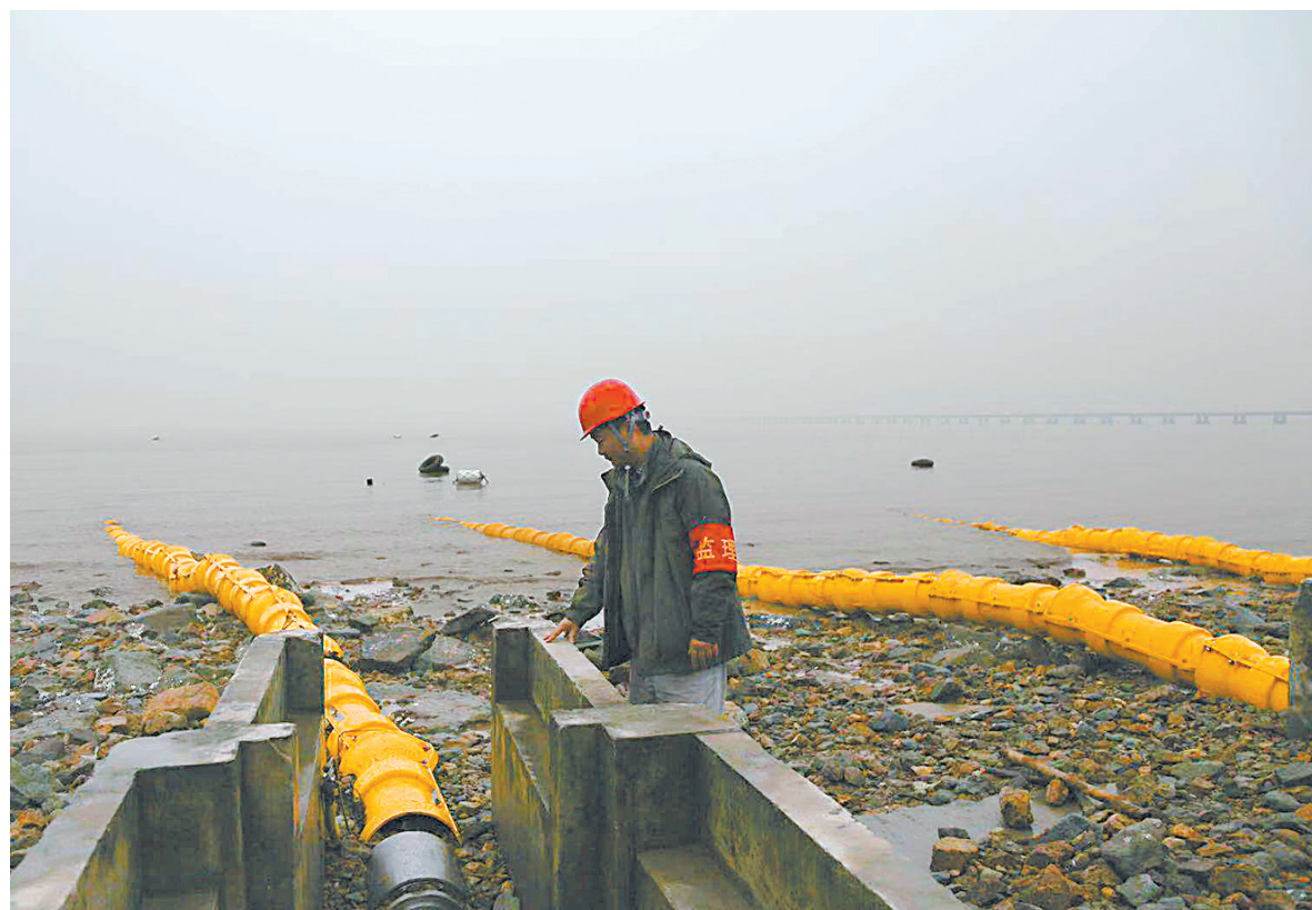
镇海新泓口堤岸,电气试验现场。
