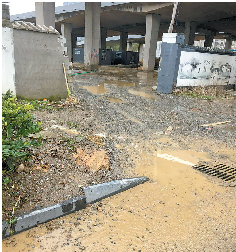
昨日下午,凤起北路东侧“宁波东”“宁波”高速出入口景观提升工程II标段出入口依旧泥泞不堪。(孔祥挺 摄)
