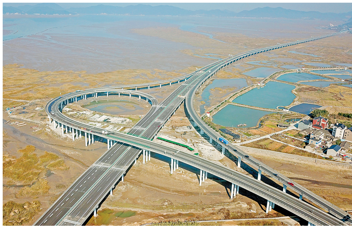
这是航拍的三门湾大桥及接线工程(象山互通段)。
