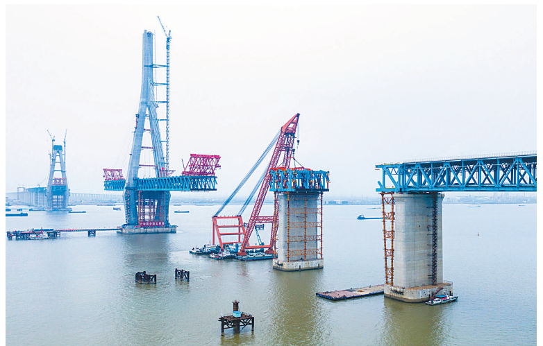
这是1月29日拍摄的沪通长江大桥27号辅助墩第3段节间钢梁吊装施工现场（无人机拍摄）。 1月29日，沪通长江大桥27号辅助墩第3段节间钢梁吊装对接成功，标志着主航道桥墩顶钢梁架梁施工全部完成。（新华社发）
